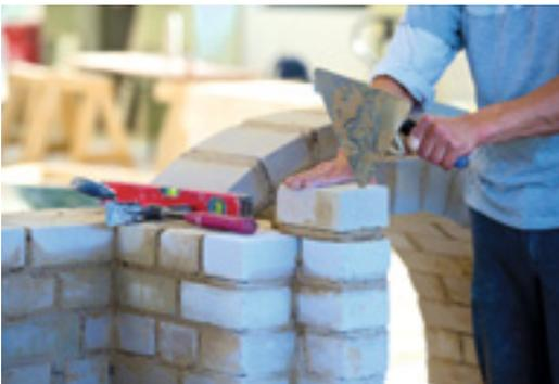
Schalungsarbeiten und traditionelles Rundbogenmauern gehören ebenso zum Berufsbild des Maurers wie Kenntnisse über Bauwerkserhaltung, Sanierung und Statik.
